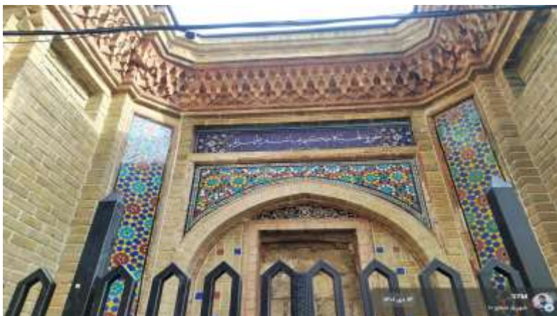
شکل شماره پانزده- مسجد و مدرسه مادرشاه (مدرسه حکیم هاشم) ساخته آسیه خانم مهدعلیا مادر فتحعلی شاه
